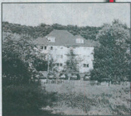
Alte Rothenfelder Straße
